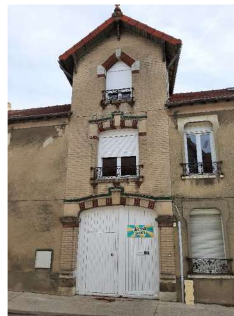
Ancien presbytère à Freneuse
