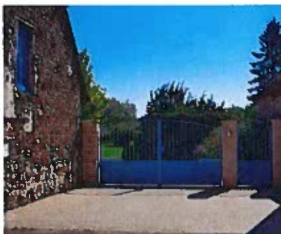
Façades anciennes et portail au vocabulaire pavillonnaire
