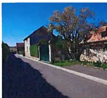
Un arbre conservé lors de la requalification de la voirie
